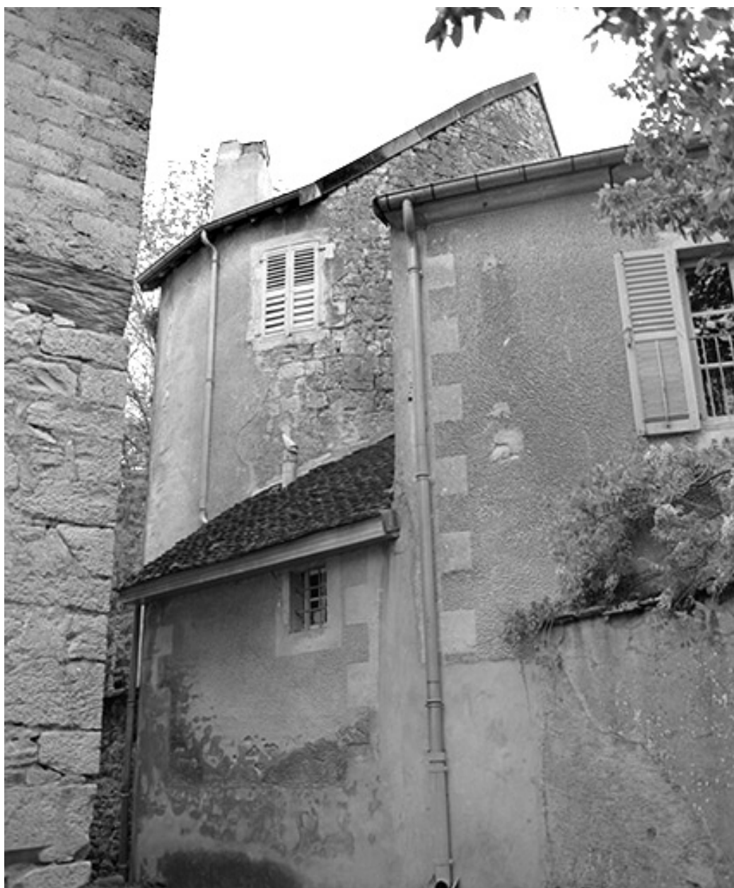
Détail : tourelle dans la maison section AI parcelle 90.
