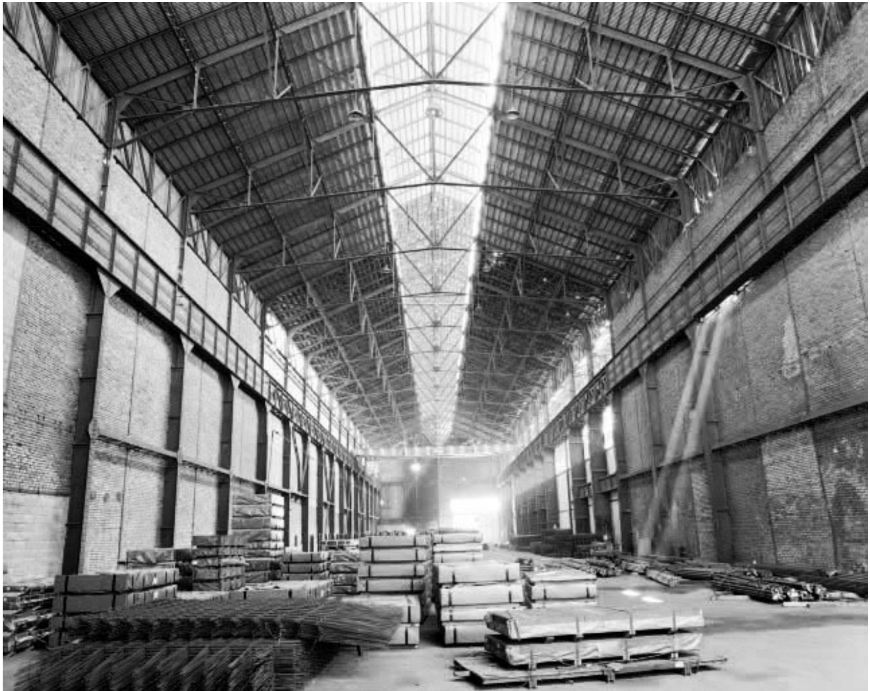
Vue intérieure de la halle centrale de l'aciérie en 1981. Cadrage horizontal.
