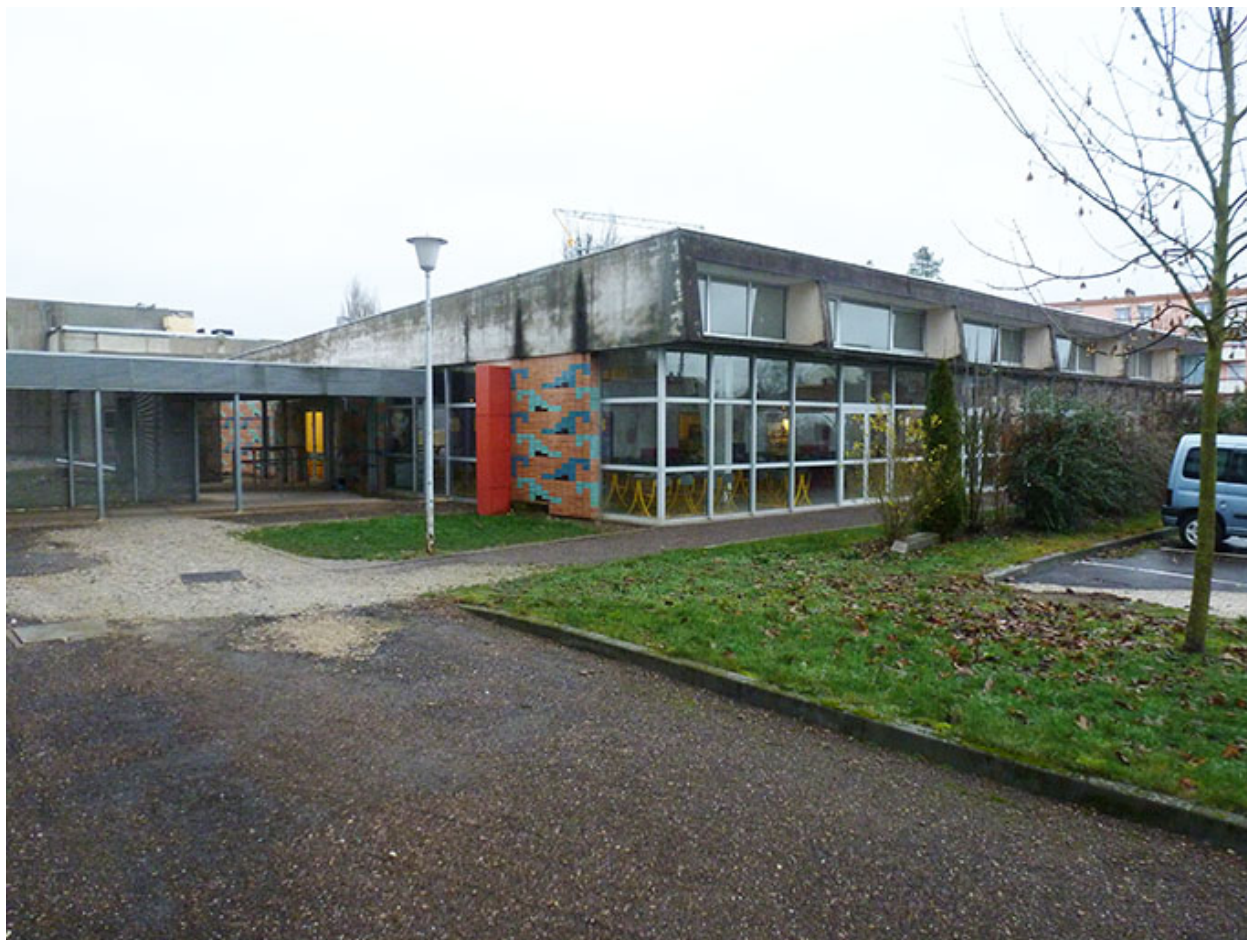
Angle sud-ouest de la cantine (en 2012)
