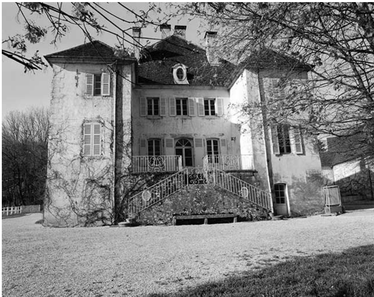
Logis : façade nord.
