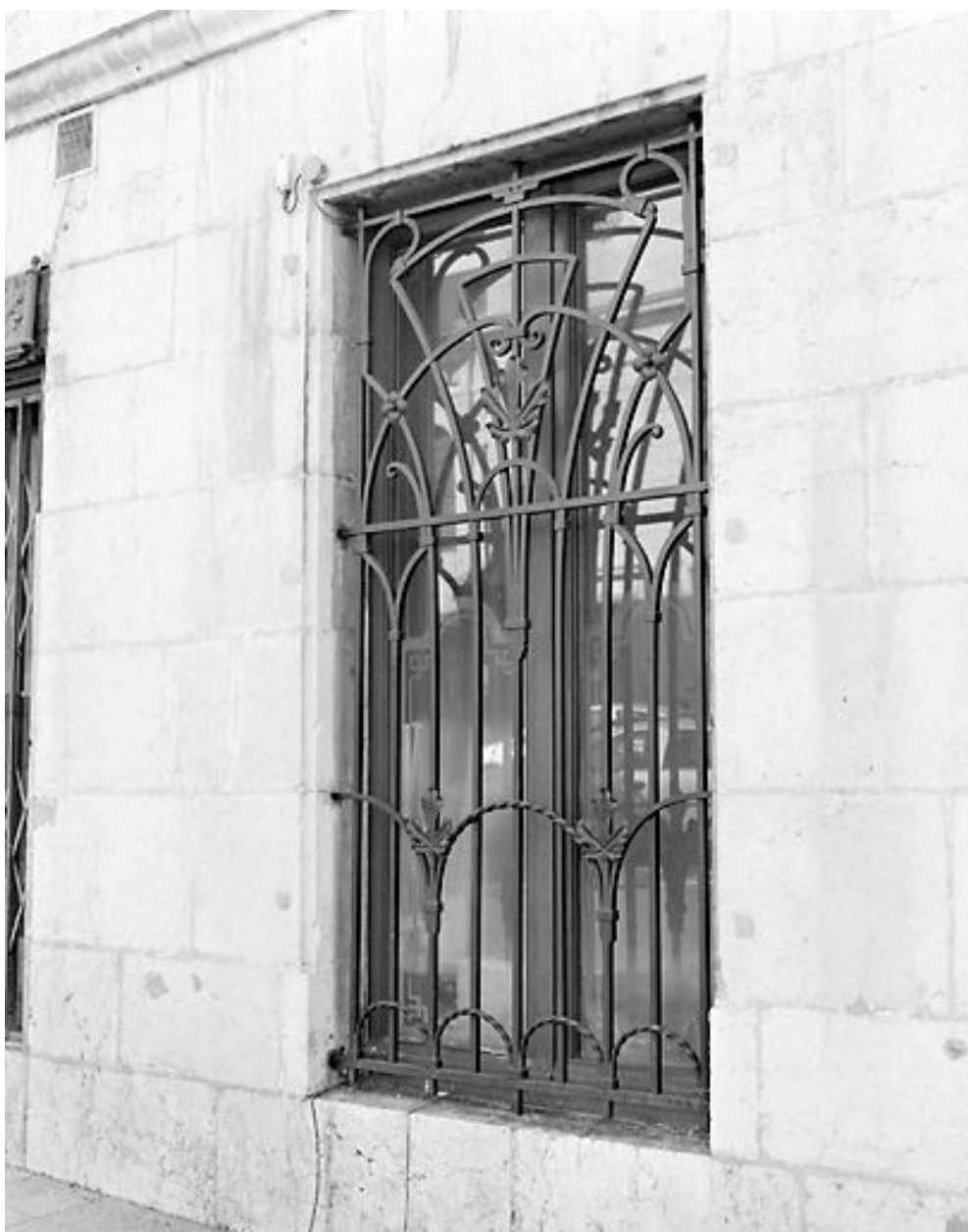
Façade latérale gauche : grille Art déco.
