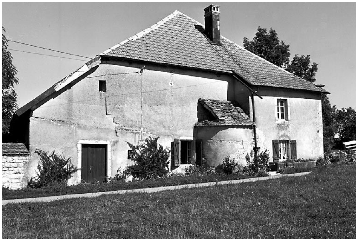
Ferme située à Echevannes.
