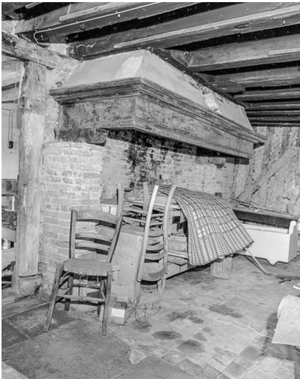
Ferme n° 16 : cheminée de la pièce d'habitation.
