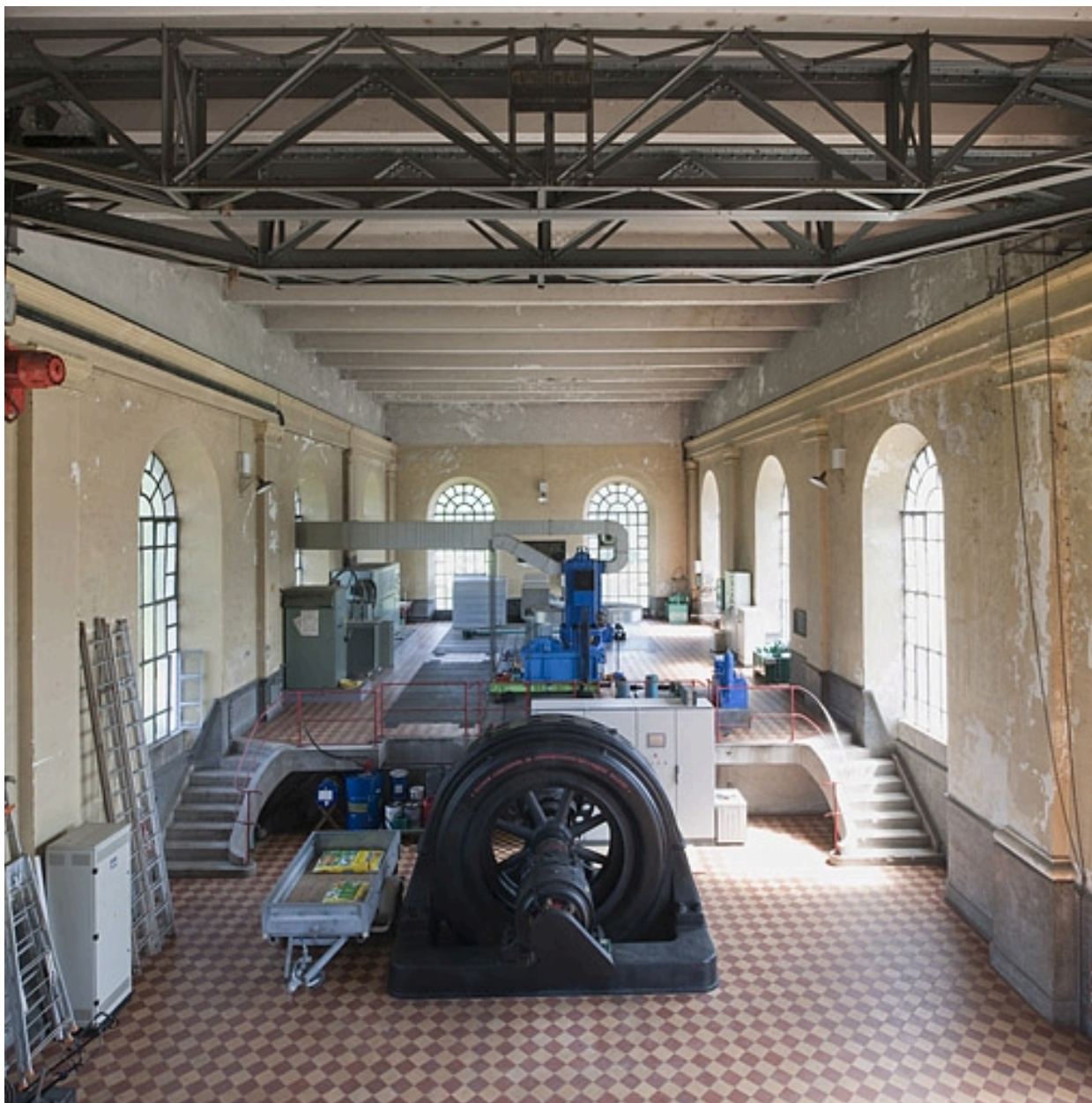
Salle de la centrale hydroélectrique de Mathay.
