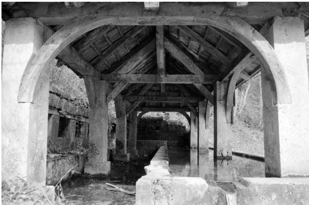
Intérieur de l'édifice.
