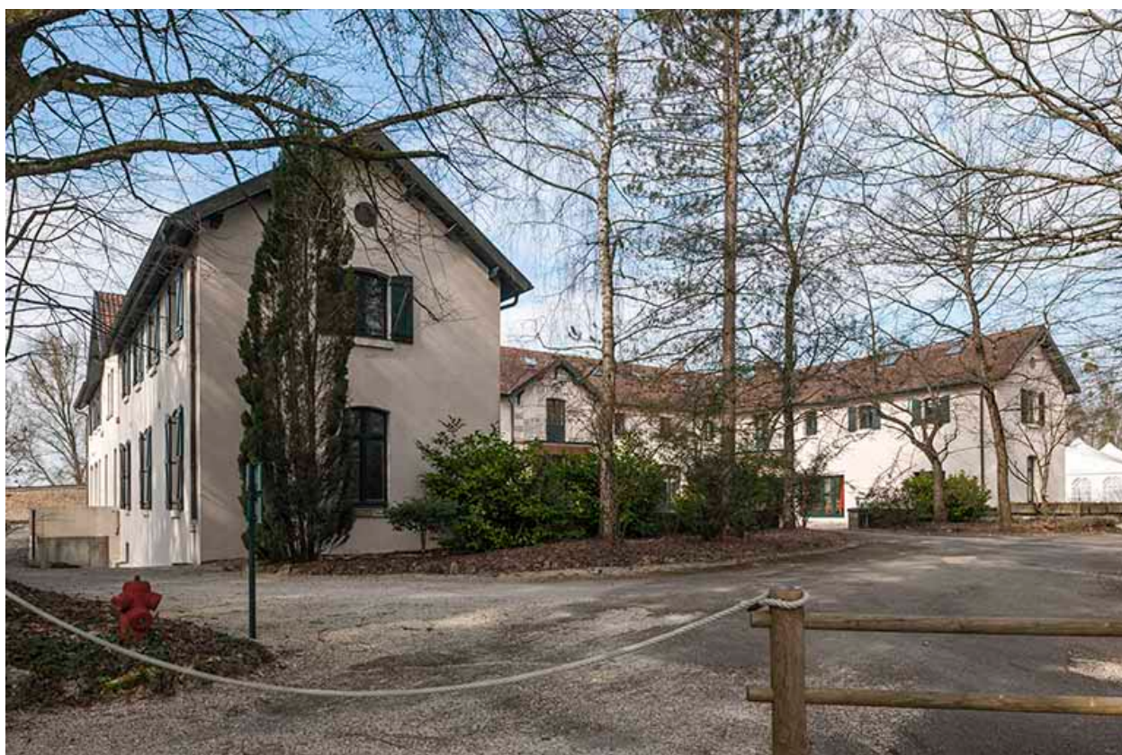
Bâtiment des communs. Vue depuis le sud-est.
