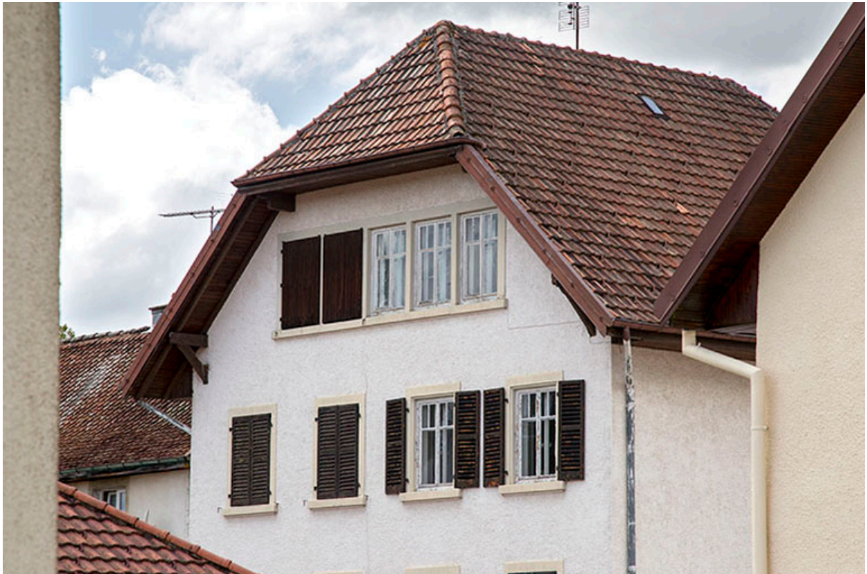
Façade postérieure : fenêtres de l'étage carré et de l'étage en surcroît.
