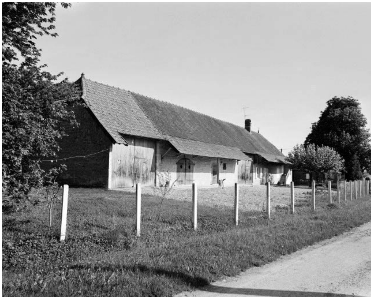
Ferme située rue de Jousseau : façade antérieure.
