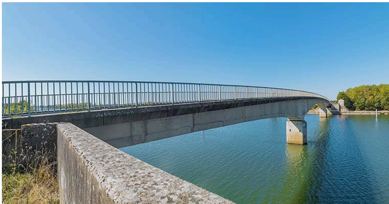
Vue d'ensemble du pont de Thorey depuis la culée de la rive gauche.
