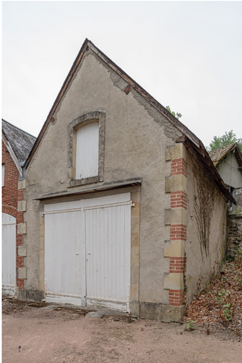
Mur-pignon du corps de droite.
