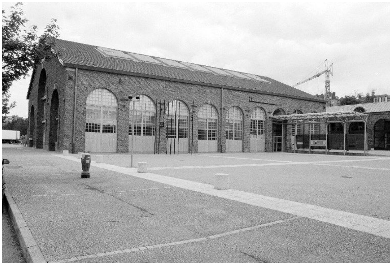
La halle des grues et des locos vue du nord-ouest.
