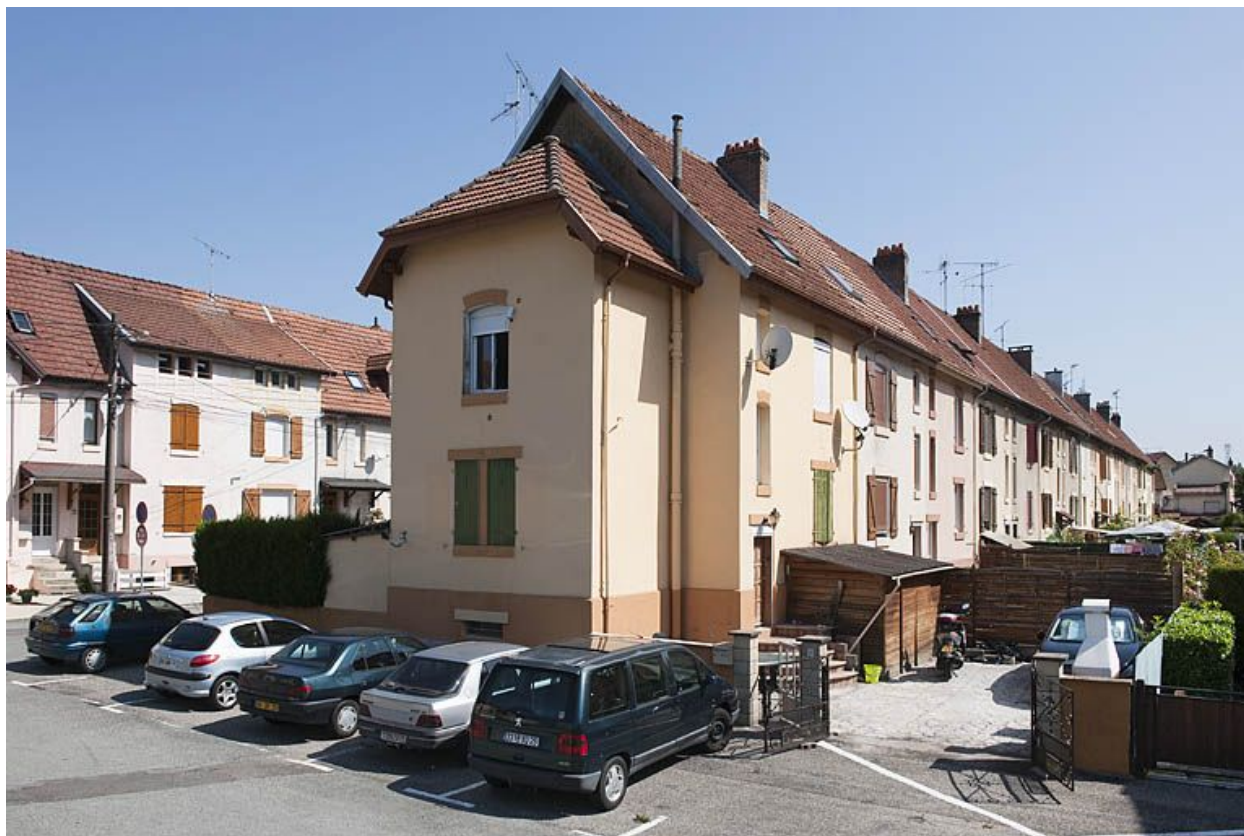
Immeuble rue de Flandres depuis le sud-ouest.
