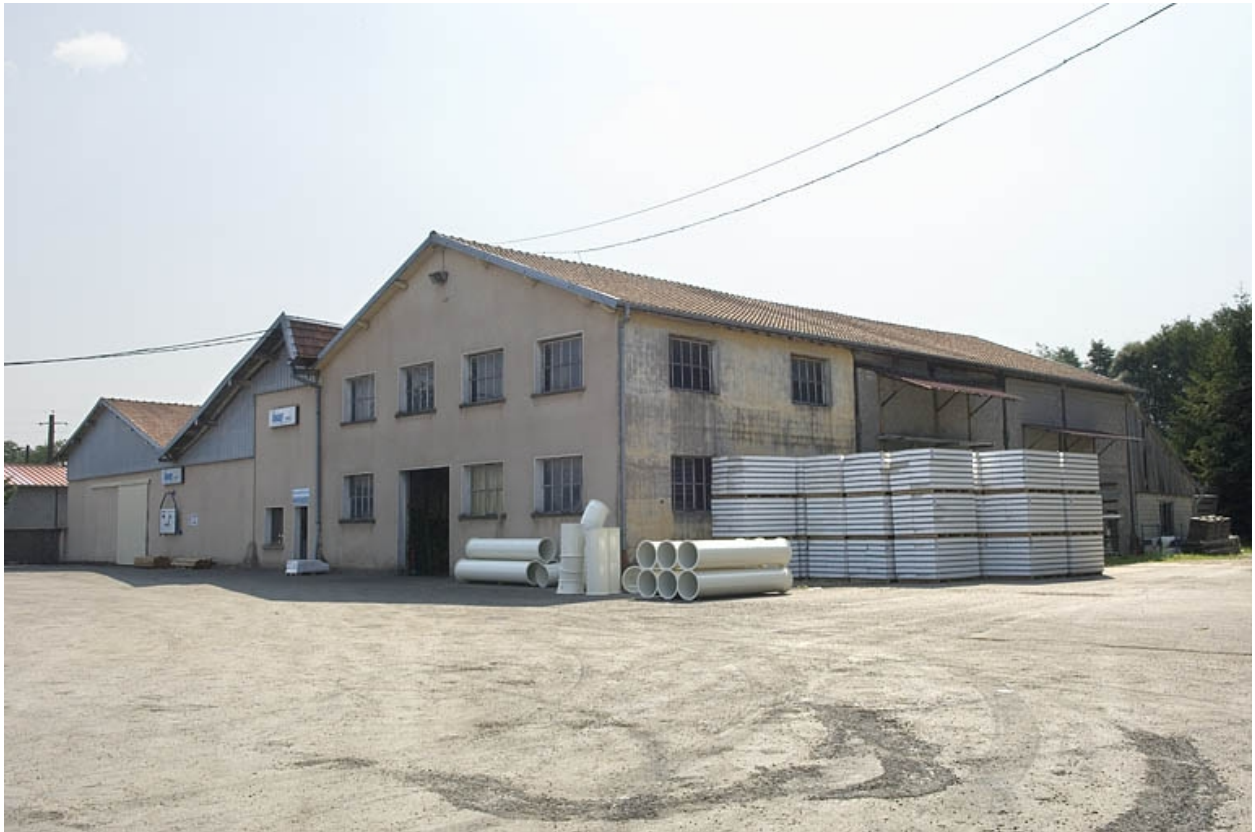
Magasin industriel (ancien four culée).
