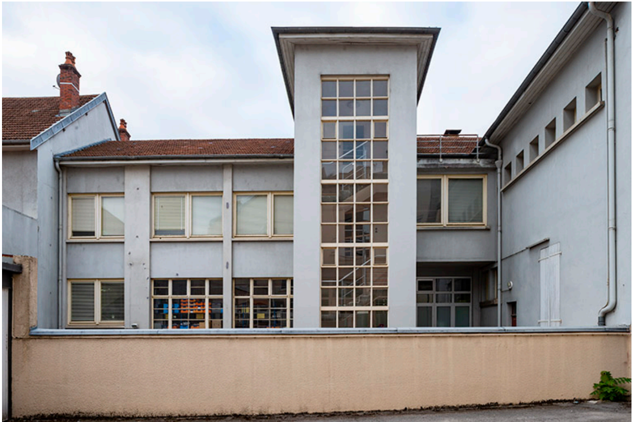
Façade sur cour.
