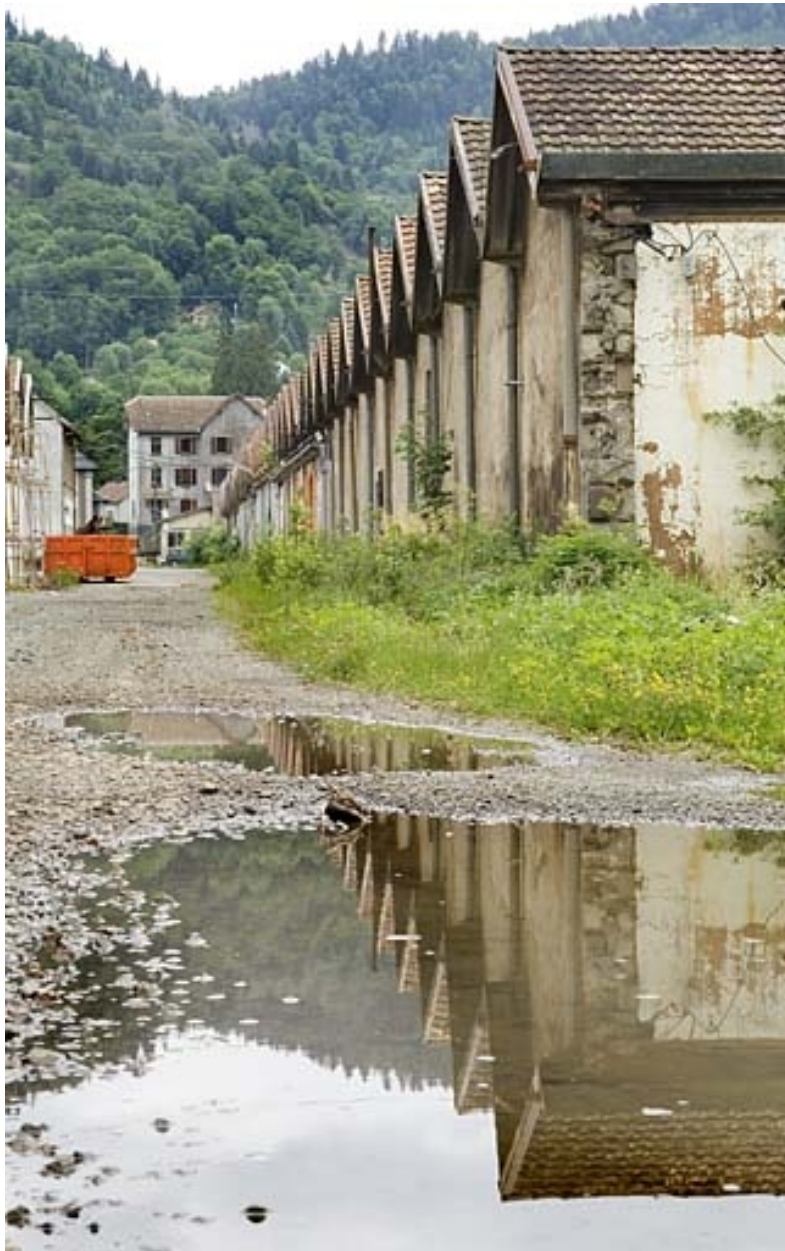
Pignons des sheds de l'atelier depuis le sud.
