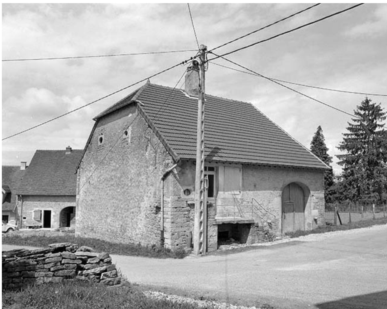
Ferme située chemin du Village.
