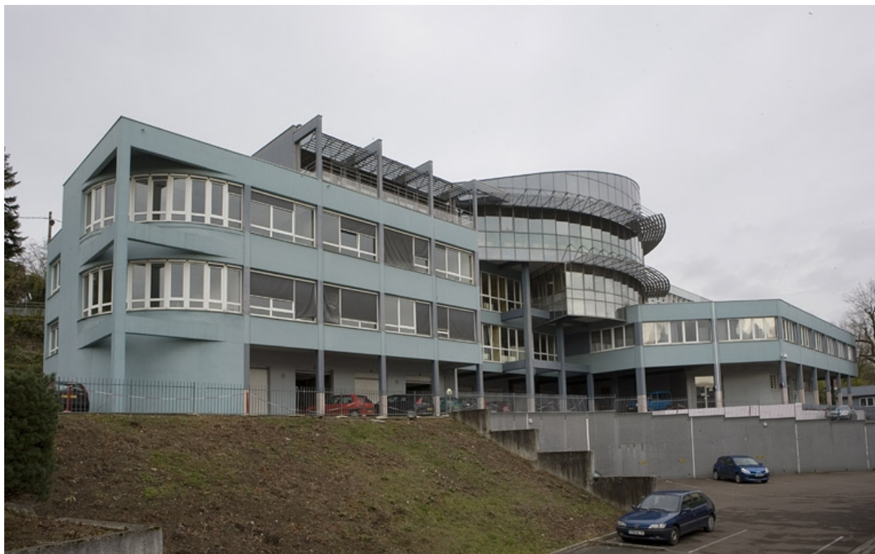
Vue d'ensemble bâtiment D depuis parking.
