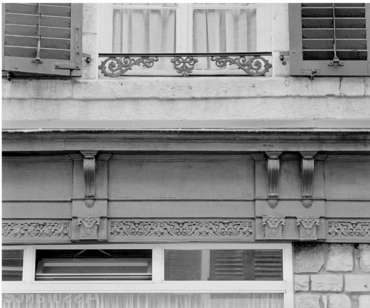
Façade sur rue, vestige de l'ancienne devanture.
