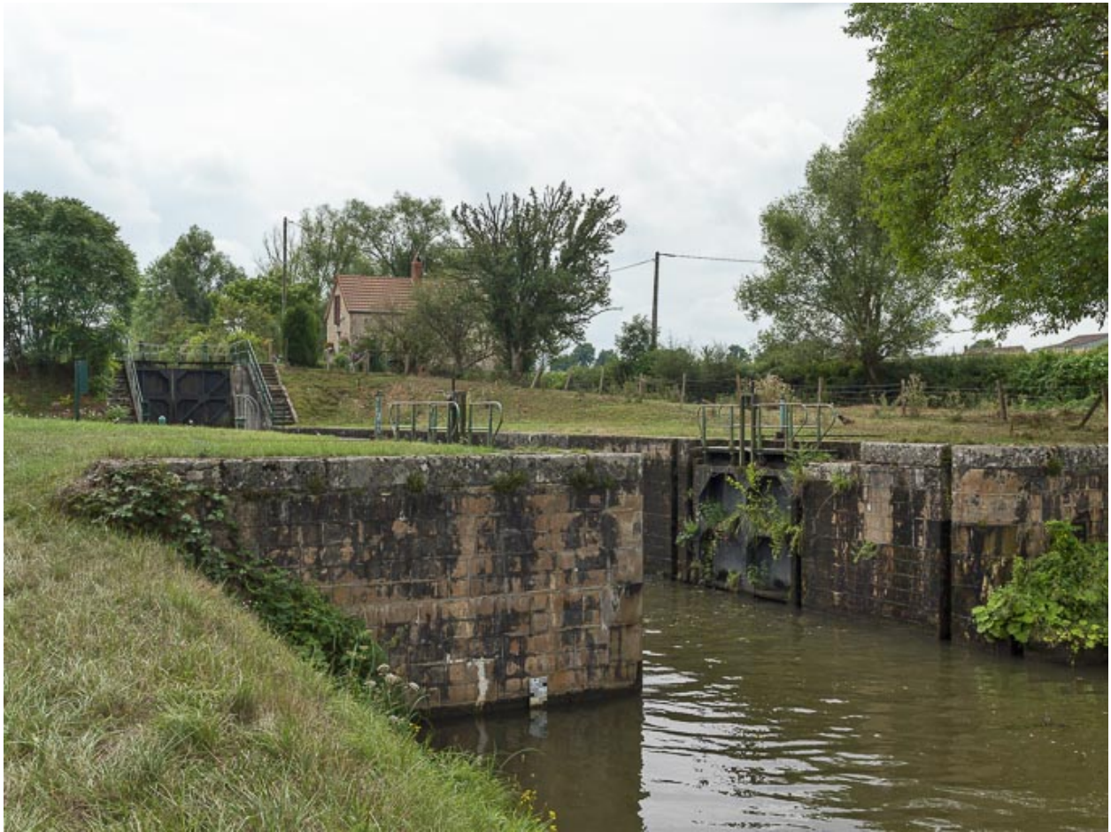
Le second sas, vu d'aval.
