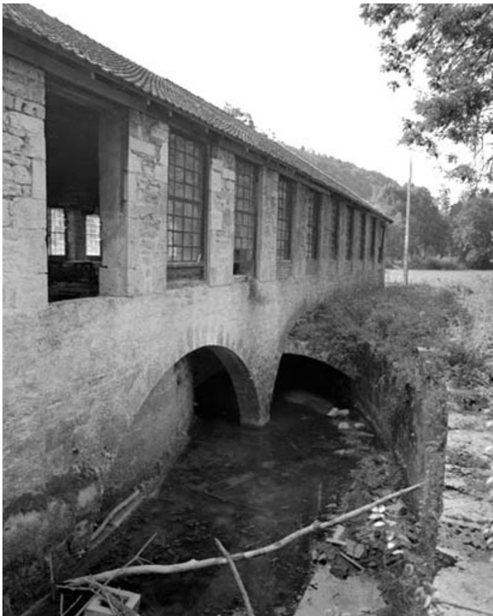
Canal passant sous la clouterie.
