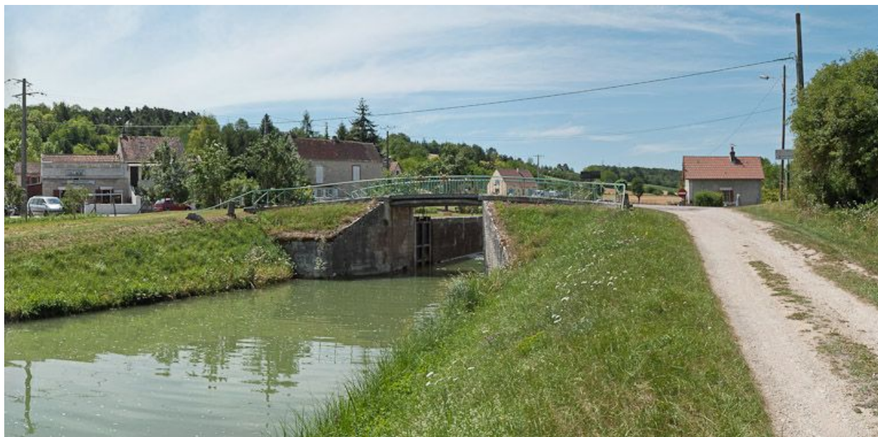
Vue du pont depuis l'aval.
