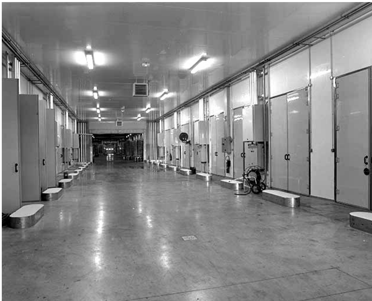
Couloir central des pièces d'affinage.
