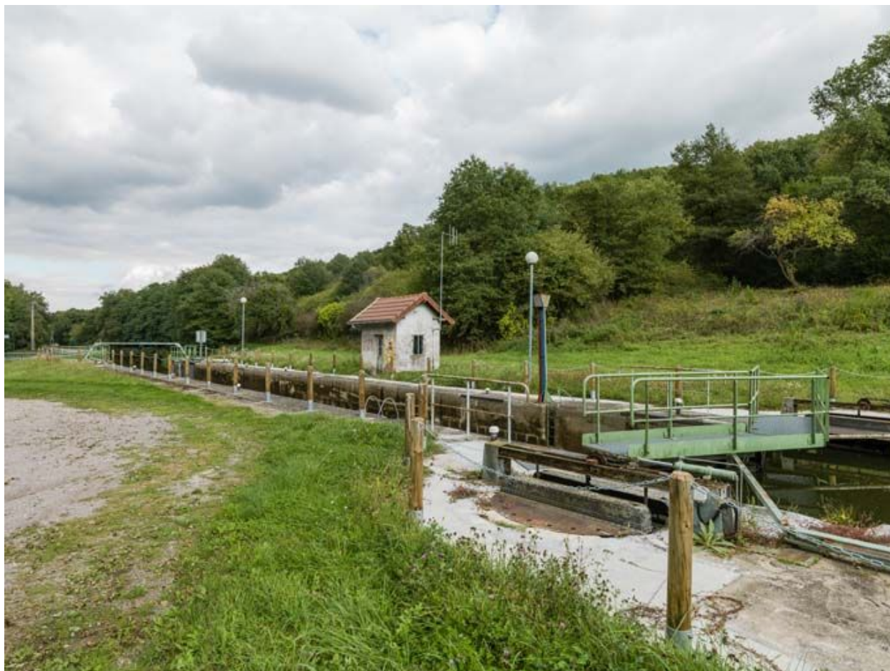
Vue d'ensemble du site d'écluse.
