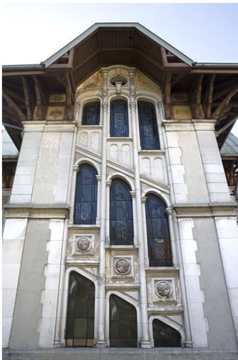
Elévation latérale gauche, en contre-plongée.
