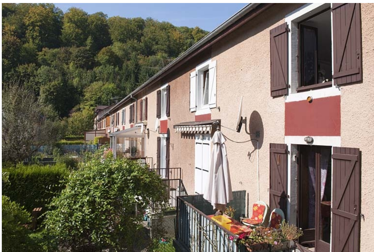
Caserne K. Façade postérieure.
