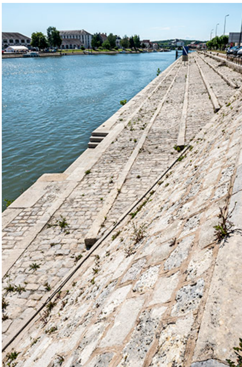
Détail de la maçonnerie du quai.
