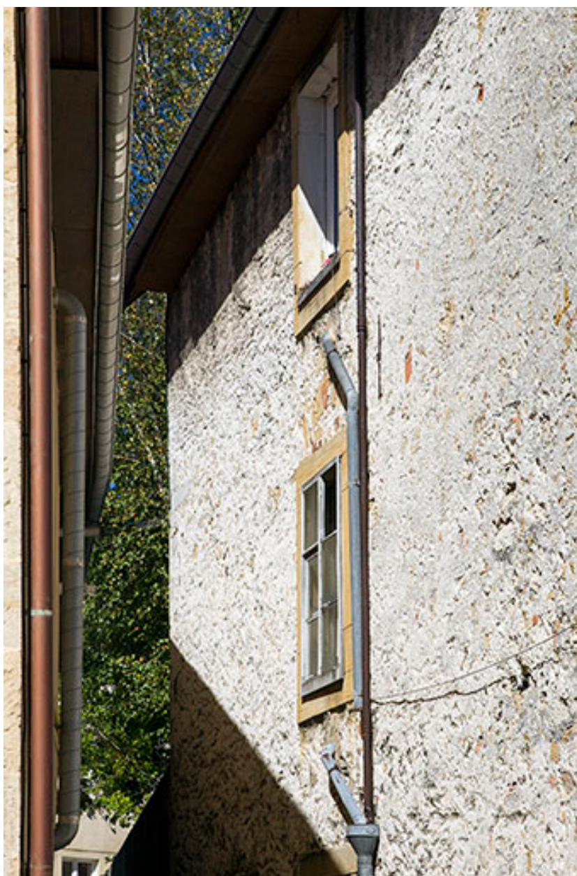
Baies sur le mur ouest.
