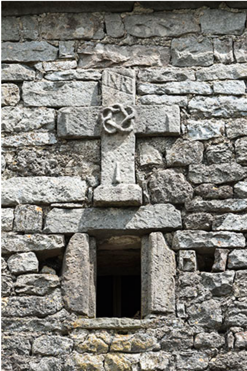
Détail de la croix sous la demi-croupe du mur pignon 16 rue des Vosges.
