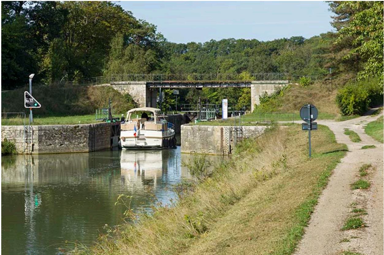
Bateau en amont de l'écluse à sas.
