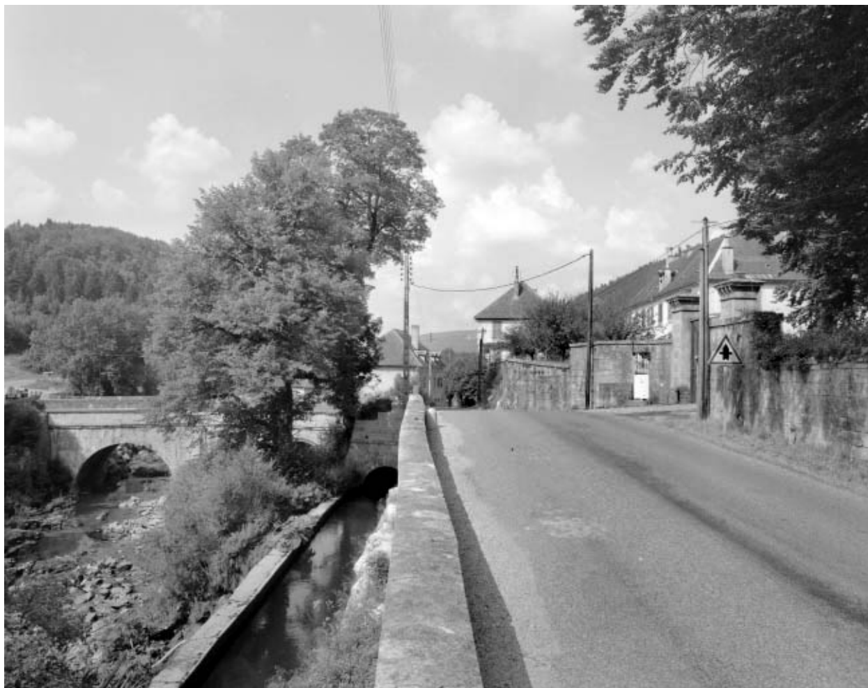
Pont et canal d'amenée, vus d'aval.
