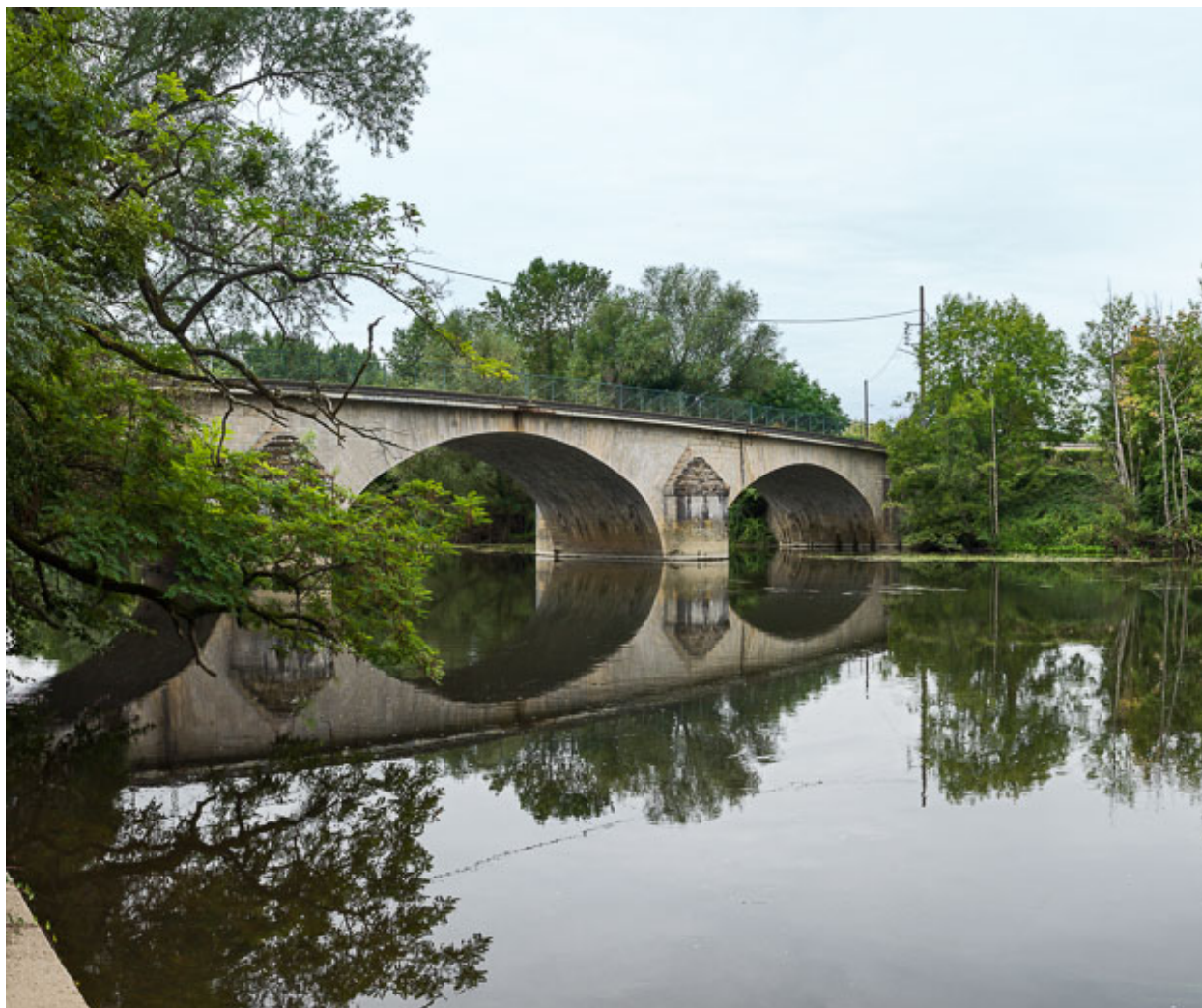
Vue d'ensemble du pont.
