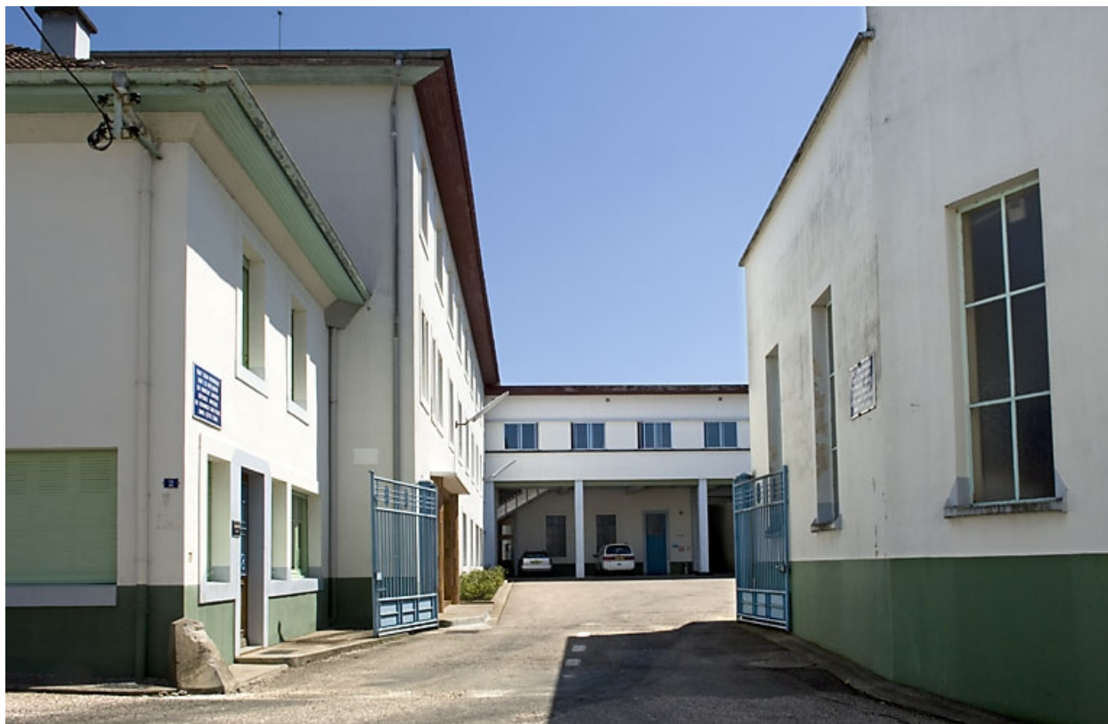
Entrée de l'usine.
