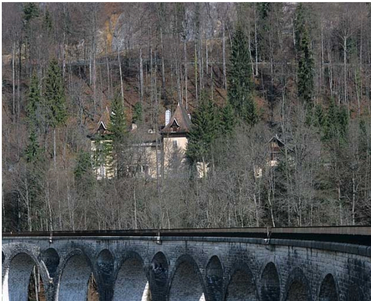
Vue d'ensemble rapprochée, depuis le sud-est.
