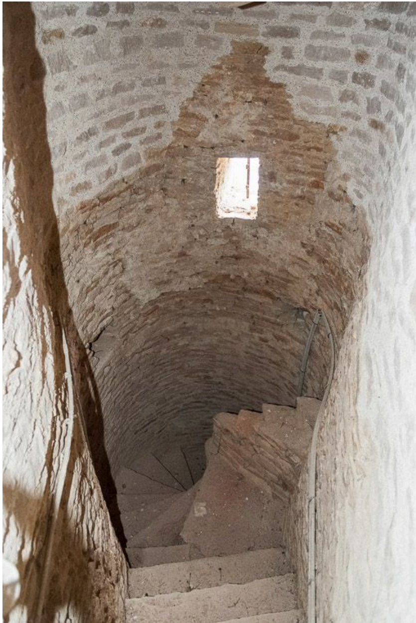
Partie supérieure de la tourelle d'escalier.
