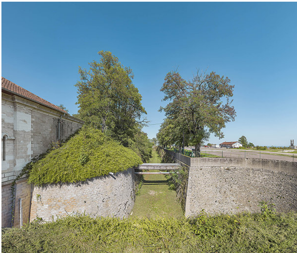
Fossé du front de gorge.
