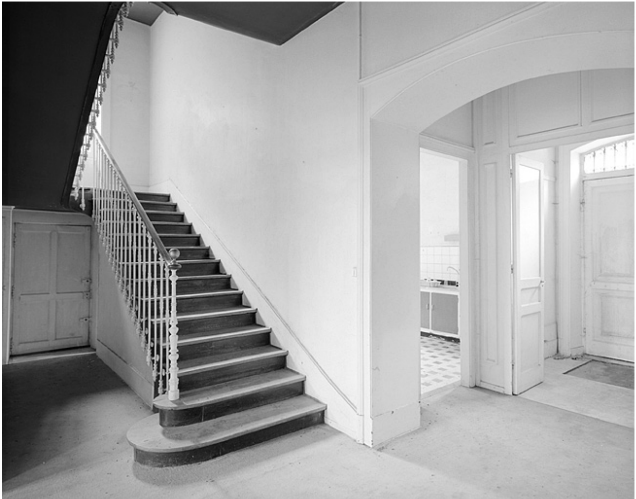
Partie sud : maison du directeur, hall d'entrée et escalier.
