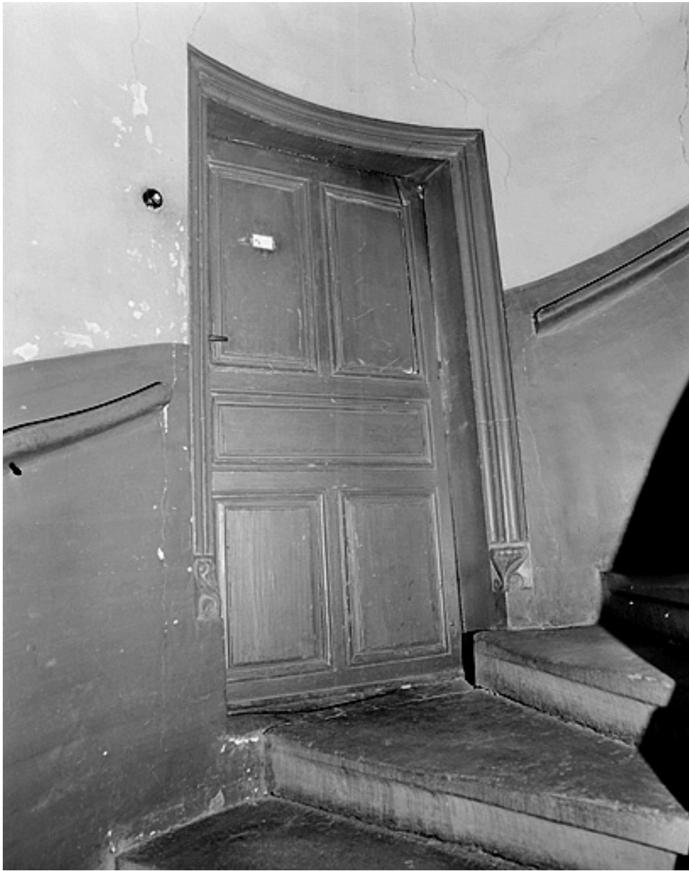
Escalier. Porte du deuxième étage.
