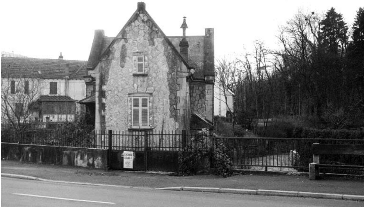
Façade latérale gauche.
