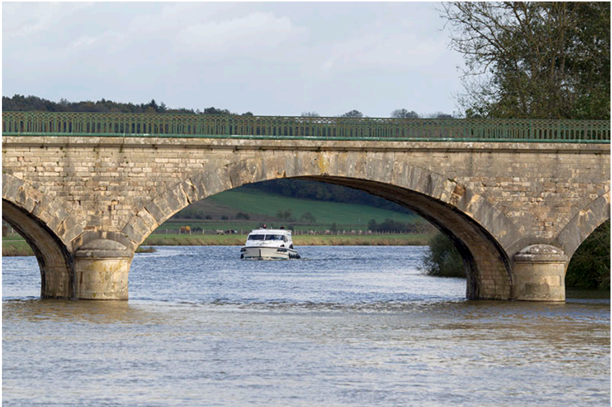
Détail d'une arche maçonnée du pont.
