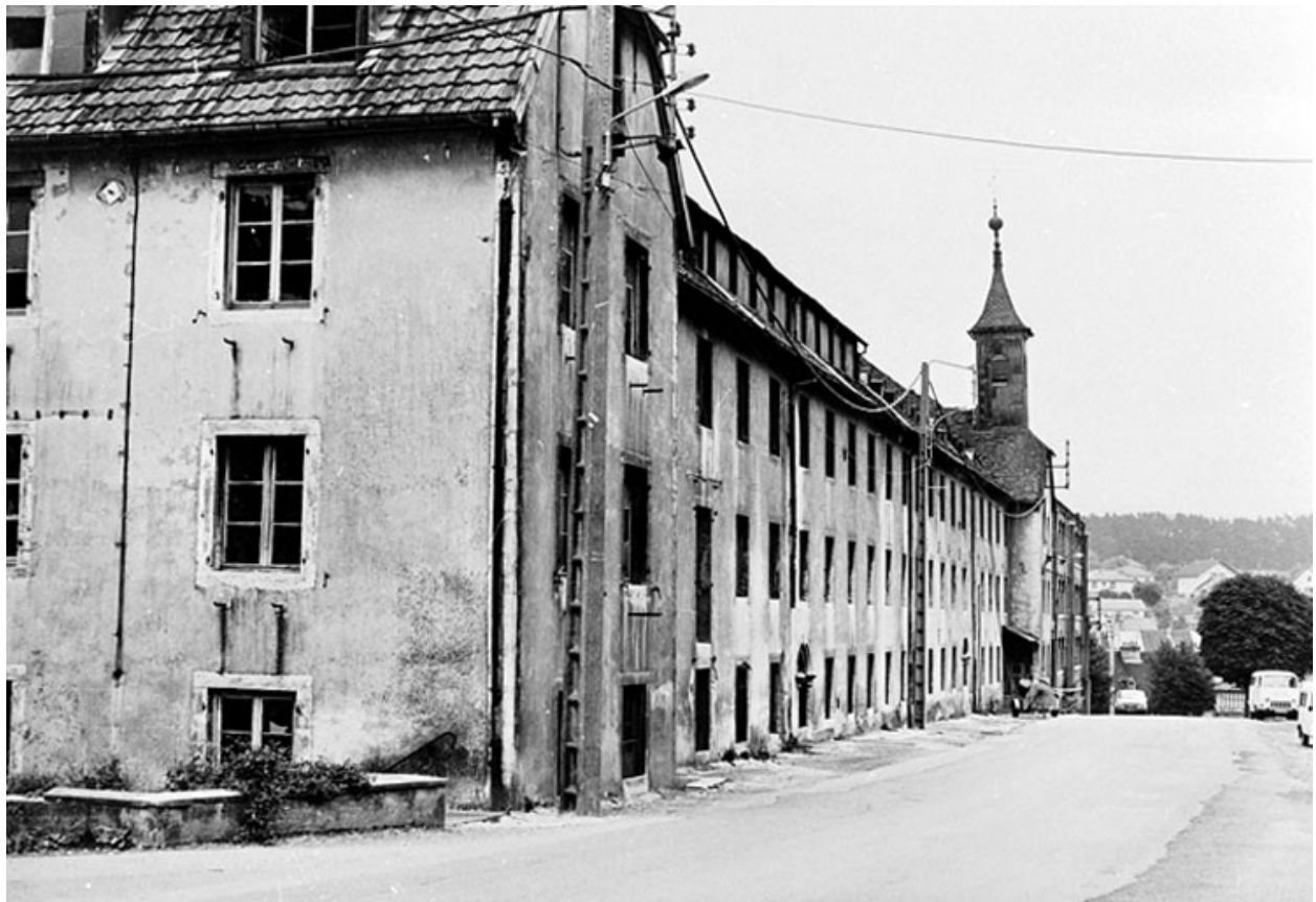
Façade sur rue avant destruction (état en 1978).
