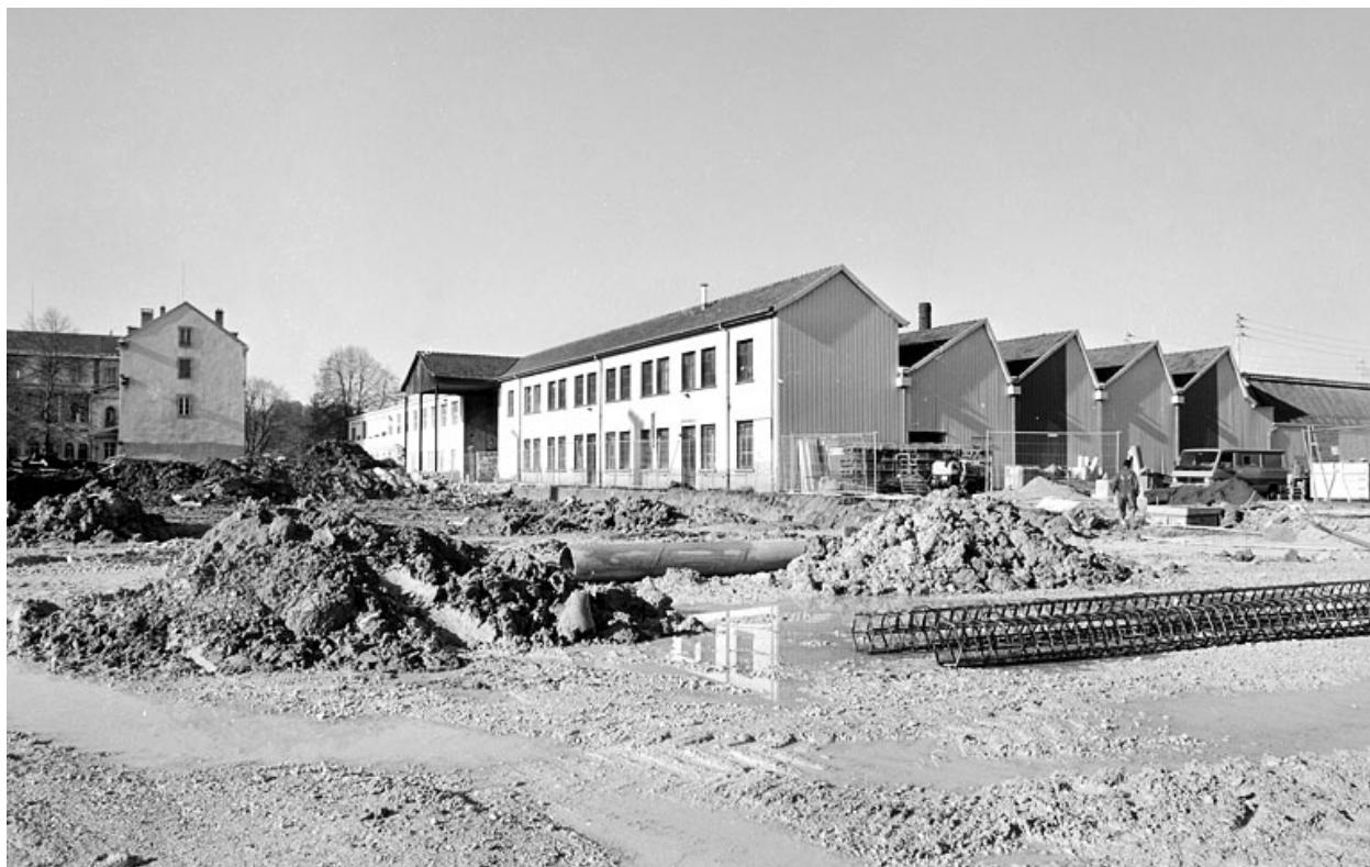
Façades postérieures des ateliers de fabrication.
