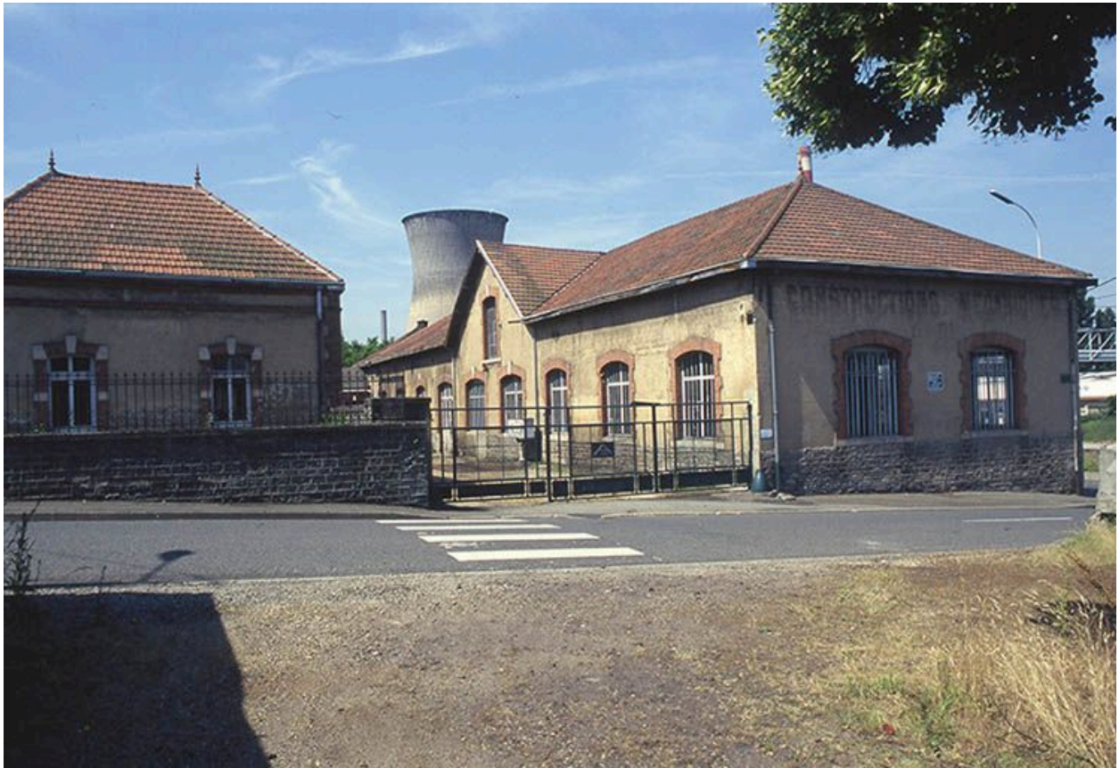
Façade postérieure de l'ancien logement du directeur, transformé en bureau après 1945.
