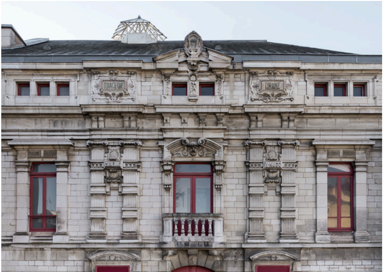
Façade latérale gauche : étage carré et attique.
