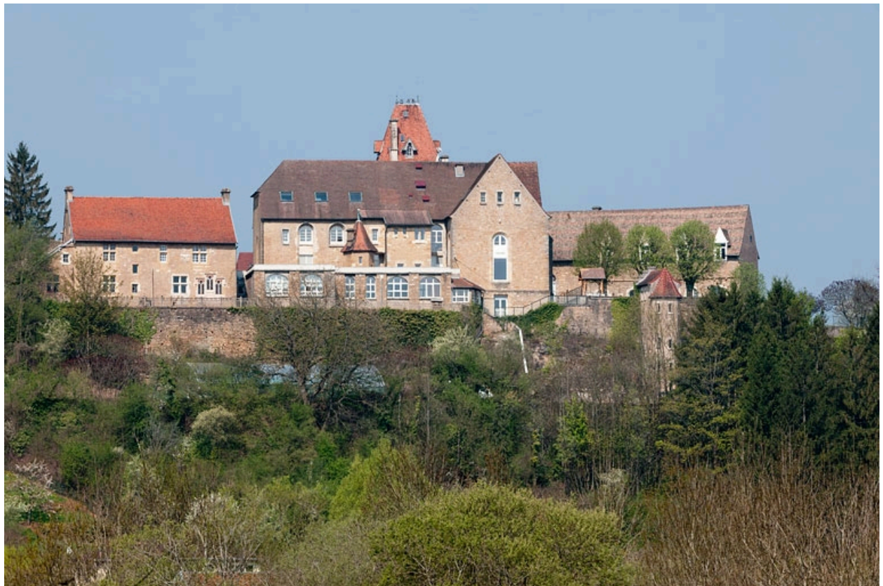
Vue générale depuis la route de Gouhelans.
