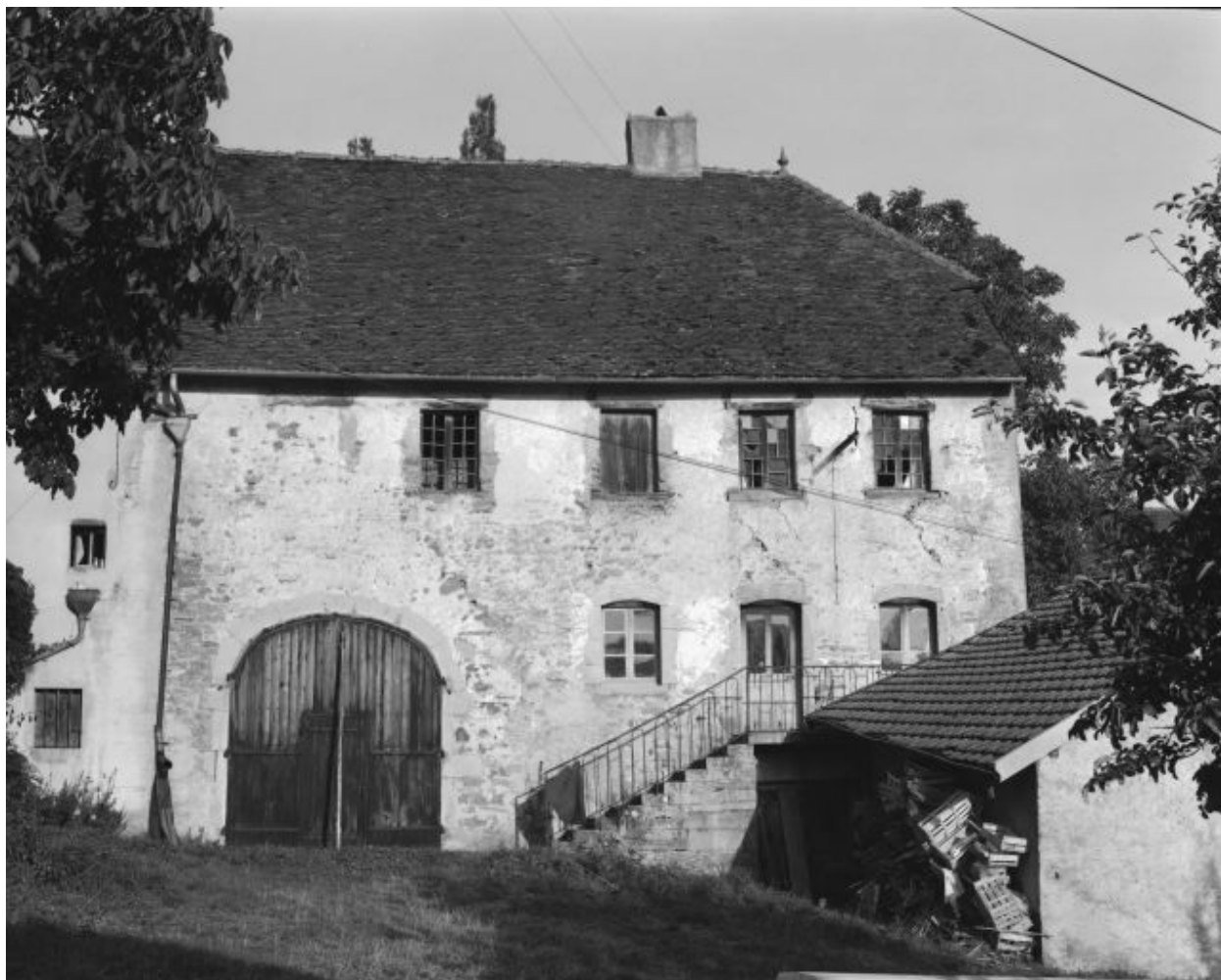
Ferme située rue du Petit Clos.
