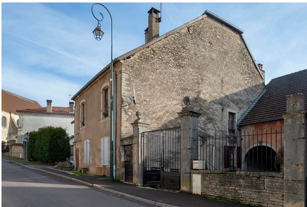
Vue de trois-quarts depuis le sud-ouest.
